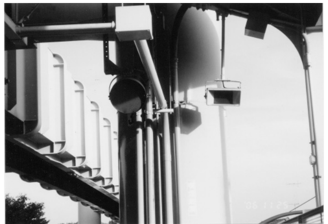
図 5. 3. 1. 1 片瀬山駅に入線するモノレールと駅の超音波スピーカ（円形）
